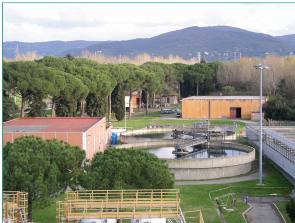
Fig. 17 - Esterno impianti dell'Anconella - fonte: archivio Publiacqua
