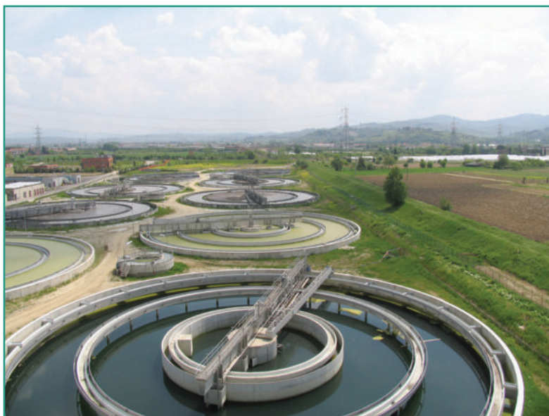
Fig. 20 - Impianto di depurazione di San Colombano - fonte: archivio Publiacqua
